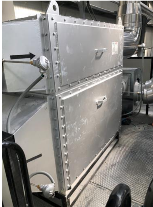
Figura 27. Fotografía del HPHE utilizado para la recuperación de calor de la zona de enfriamiento (proyecto DREAM)
